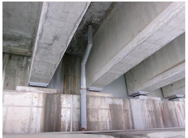
배수시설 배수관 전경
