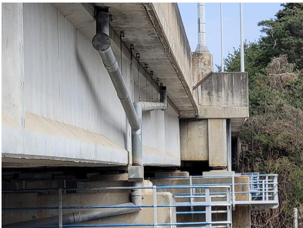
배수시설 배수관 전경
