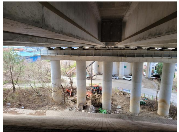
교각 P3 전경
