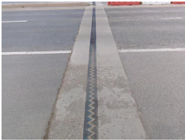
신축이음 A2 전경
